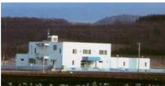
機器の更新をする農業集落排水施設(穂波)
