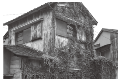
危険な住宅の解体除去に 補助金制度が！ (令和4年度の予定)
