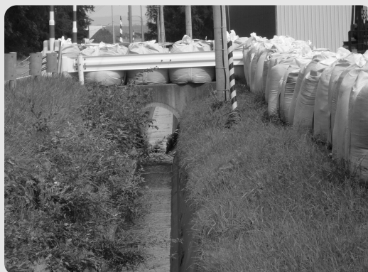
大谷排水路越水応急対策
