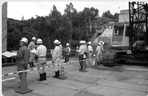
産業建設常任委員会所管事務調査時における開盛橋工事の進捗状況
