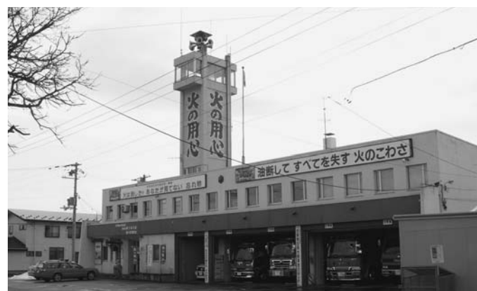
耐震調査を実施した消防庁舎
