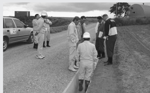
町道大谷緑丘線（大谷）災害復旧状況を調査
