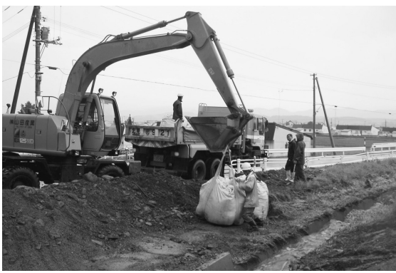
災害復旧を行っている農試川（西富）
