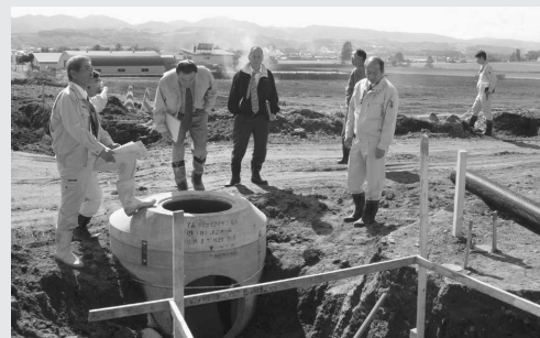
南9線道路改良工事を調査
