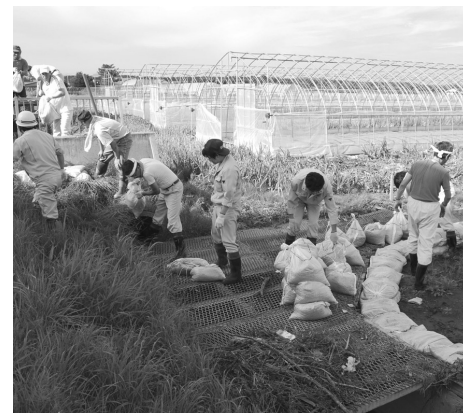
町職員による土のう設置作業
