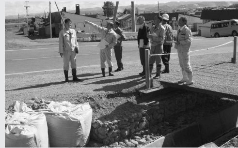
農試川（西富）災害復旧状況を調査
