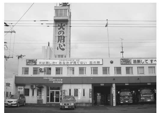
広域による一部事務組合で構成されている消防
