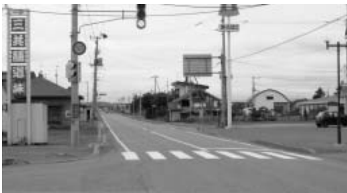
道路拡幅事業が進められている「道道北見置戸線」 日出市街
